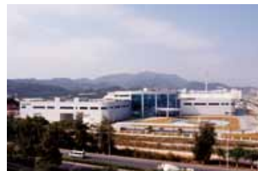
中国廈門工場：全景
